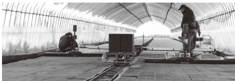
ハウス内で床伏せ作業する様子
